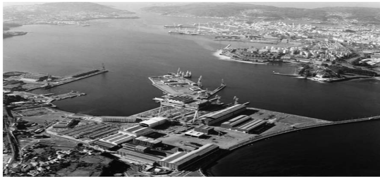
Vista a rea de las instalaciones de Navantia en Fene
