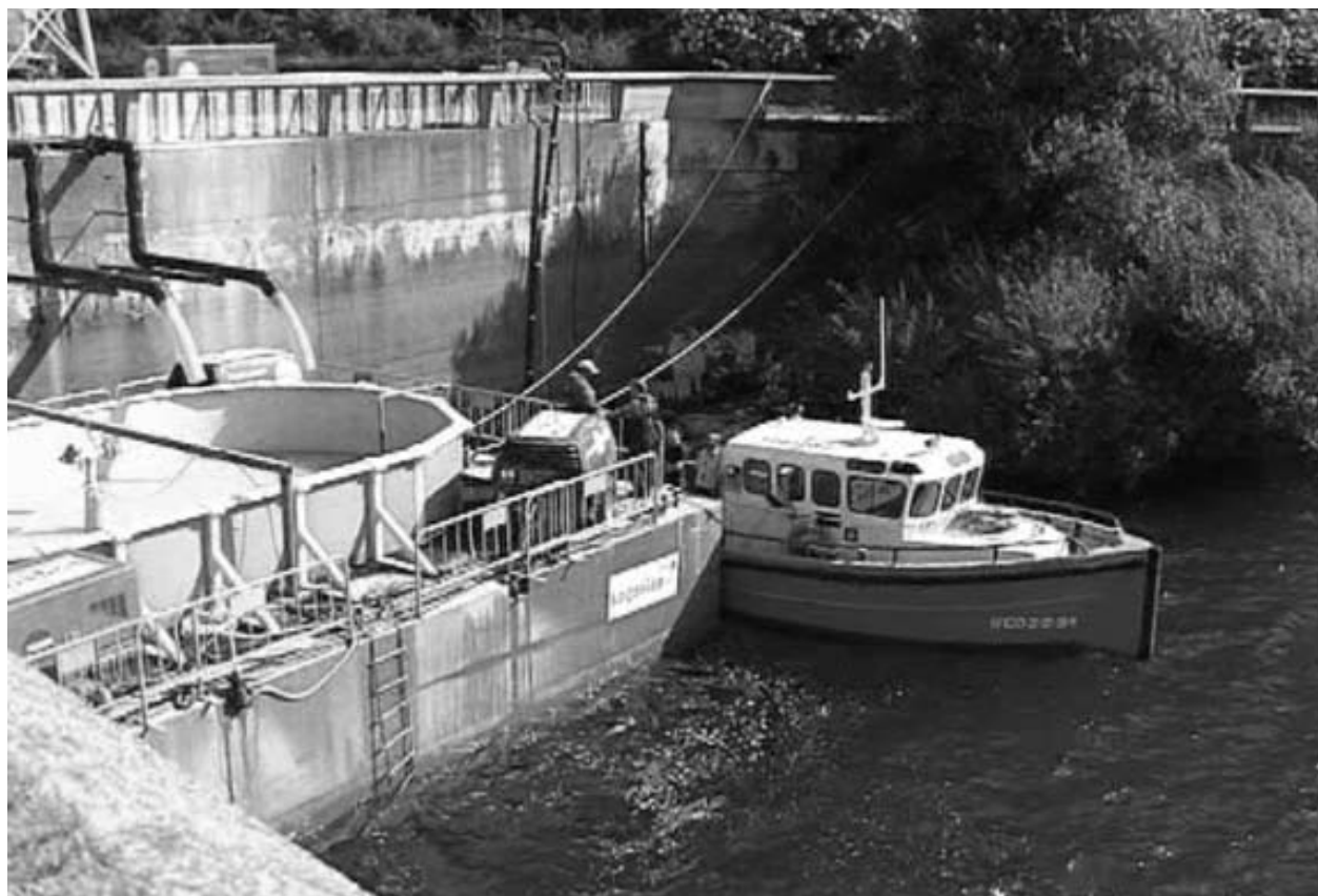
Se pretende adicionar al embalse del Eume entre 1000 y 2000 toneladas de carbonato c lcico
