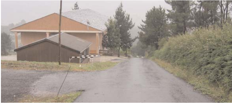
Las obras fueron realizadas por FCC a cambio de la cesión de unos locales y posteriormente ingresado su importe en la cuenta de la empresa San Martín SA en el Banco Pastor
